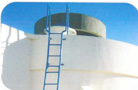
Le projet d'approvisionnement en eau potable des villages des deux communes El Oudine et Ouled Mimoune dans la province de Moulay Yaacoub
