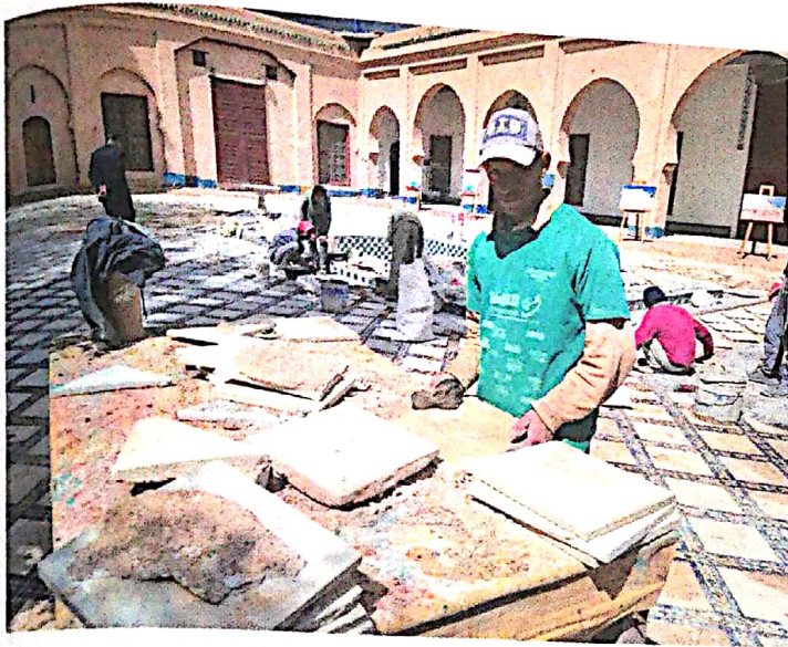
La vision royale pour la médina de Fès s'appuie sur la sauvegarde, la promotion et la valorisation du tissu ancien. Stratégie dans cette démarche, une refonte à l'identique est prônée au niveau des différents chantiers (Ph YSA)
